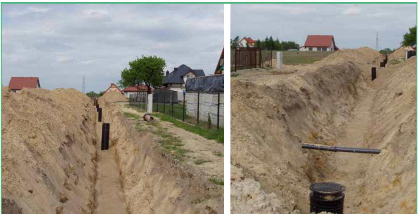
Budowa sieci kanalizacji sanitarnej z przykanalikami dla osiedla mieszkaniowego Serock
