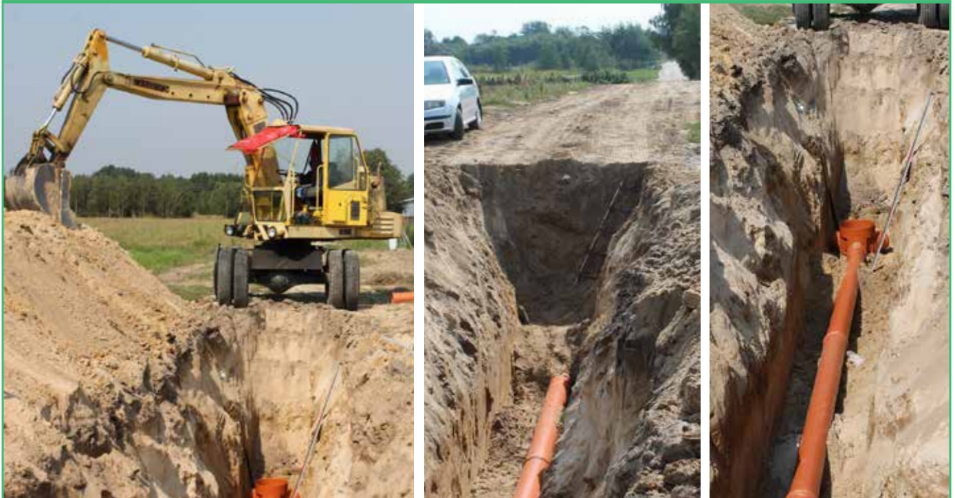
Budowa sieci kanalizacji sanitarnej z przykanalikami w miejscowości Przypisówka
