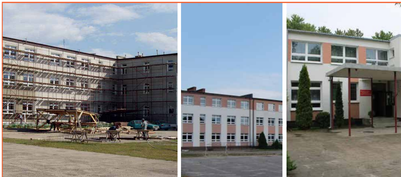
Termomodernizacja obiektów oświatowych - wymiana stolarki okiennej i drzwiowej, instalacji c. o. i pieców zasilanych olejem opalowym - szkoły w Firleju, Przypisówce, Nowym Antoninie, Woli Skromowskiej.
