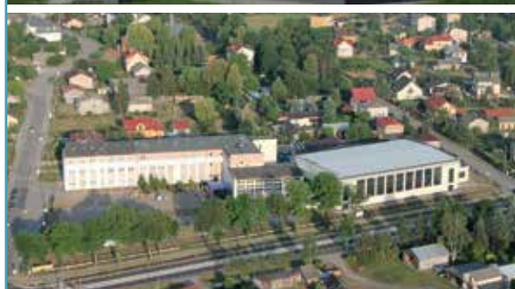
Budowa pełnowymiarowej hali sportowej przy Zespole Szkół w Firleju
