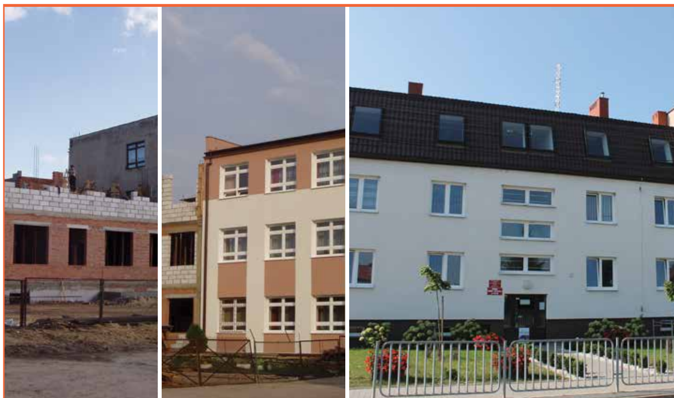
Rozbudowa Budynku Szkoły Podstawowej w Firleju - etap I (budowa łącznika i przebudowa domu nauczyciela na cele oświatowe).
